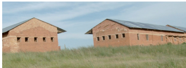
Baufortschritt im März 2012
