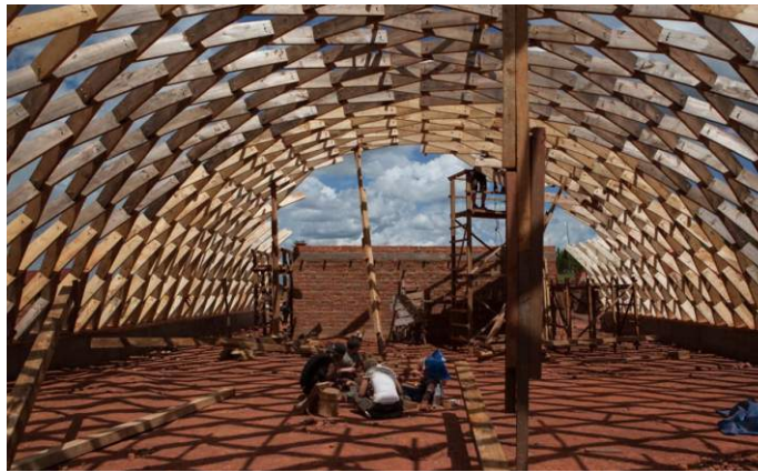
Dachstuhlarbeiten März 2015, Foto: Susanne Steinmaßl
