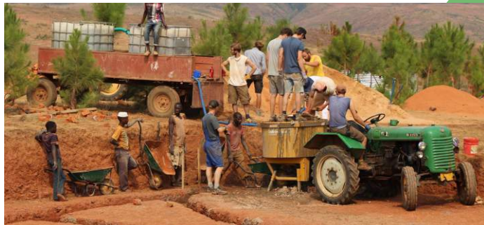
Betonieren im August 2014, Foto: TUM
